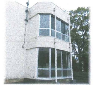
改修なった東側壁面
