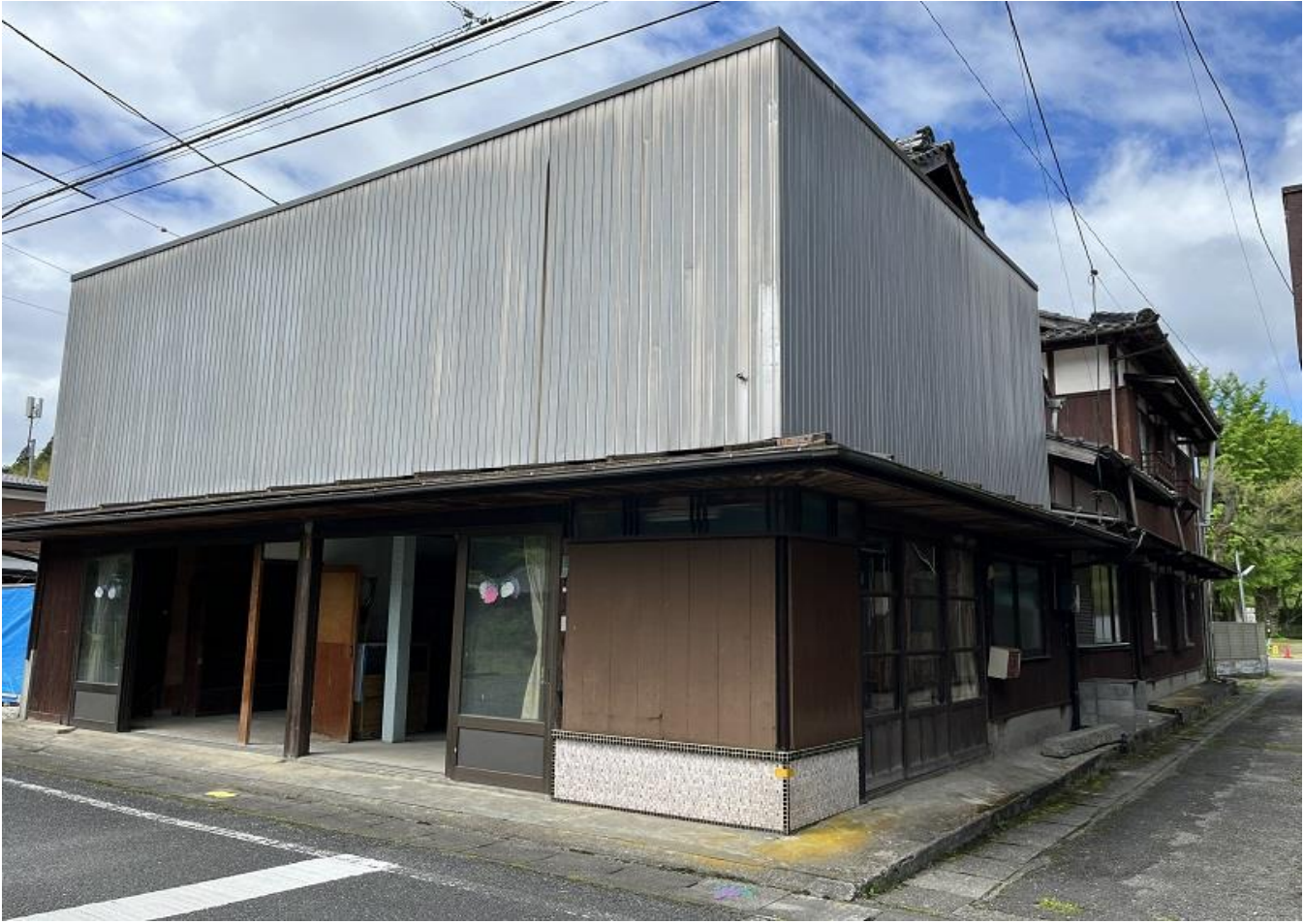
⑮外観（店舗側）
