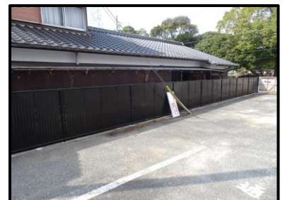
第1駐車場フェンス
