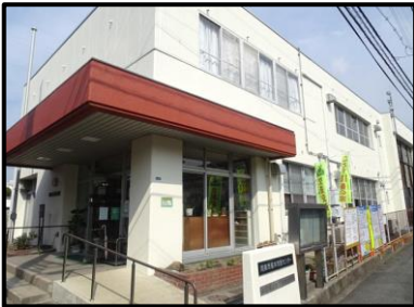
外壁塗装・玄関手すり
