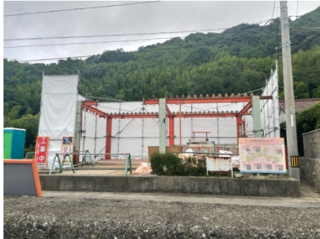
令和5年5月～解体・建て替え中
