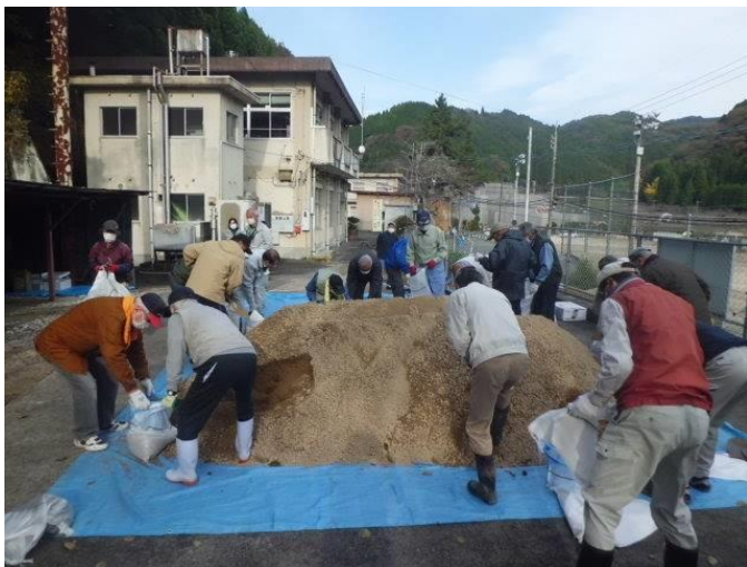
(土のうづくりの様子)
