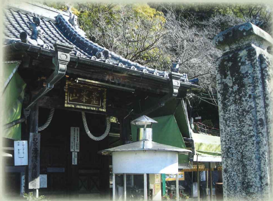
川崎観音堂本堂と門柱(右)
