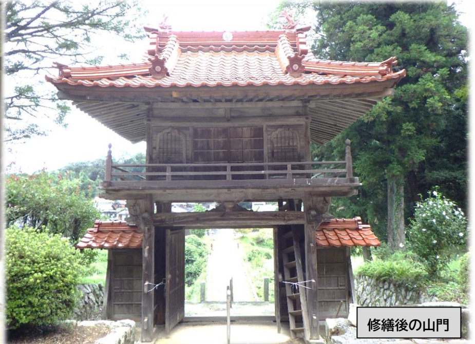
修繕後の山門(扉付近)
