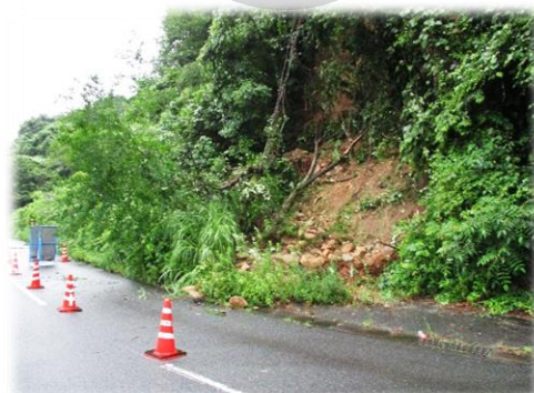
菅野湖付近の路肩や斜面が崩落。
