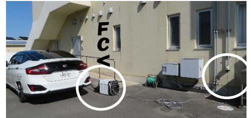
外部給電受電口
