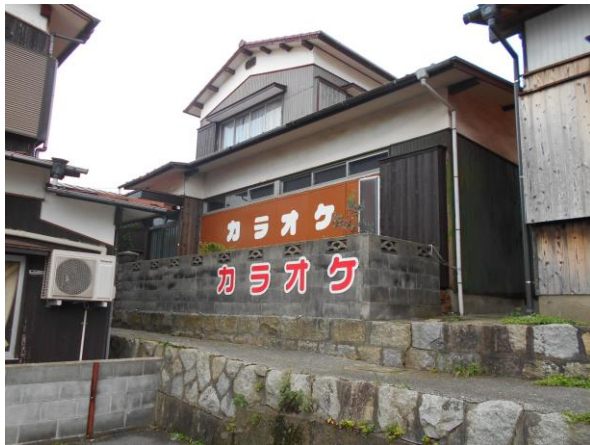
店舗外観 空き家を利用しています。
