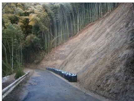
昨年5月から、土砂崩れのため通行不 能となっていた林道千石線が復旧。
