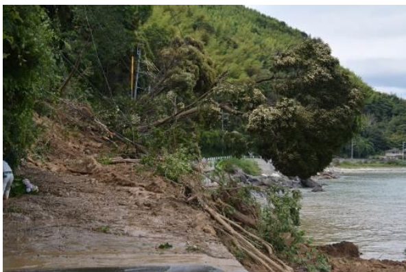
災害直後の様子(馬島側より撮影)
