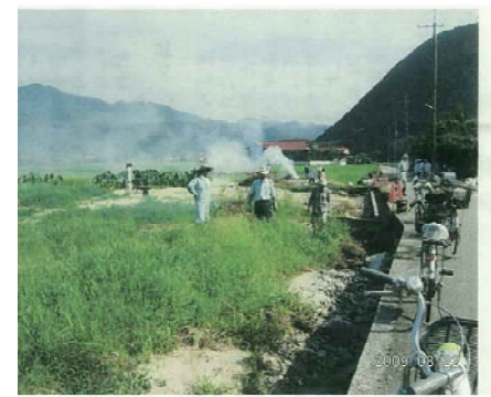
中村地区の方での災害復旧作業の様子
