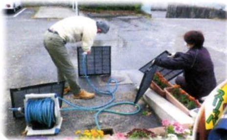
エアコンのフィルターを清掃中
