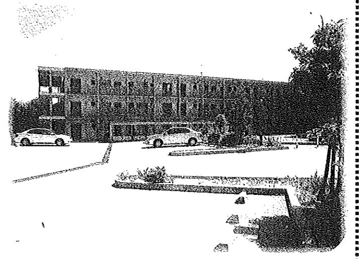
正面から見たA棟の全景
