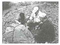
新しい給水ポンプの 防寒作業
