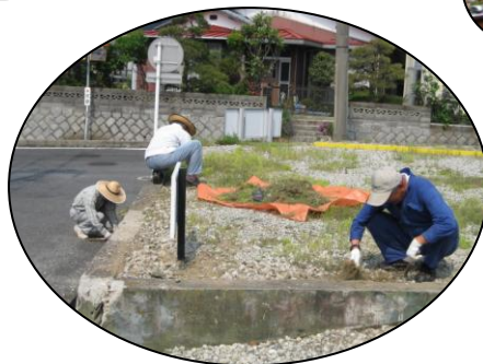
5 / 16 駐車場除草作業
