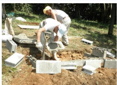
2013年9月に行われた、眺望図設置工事の様子です
