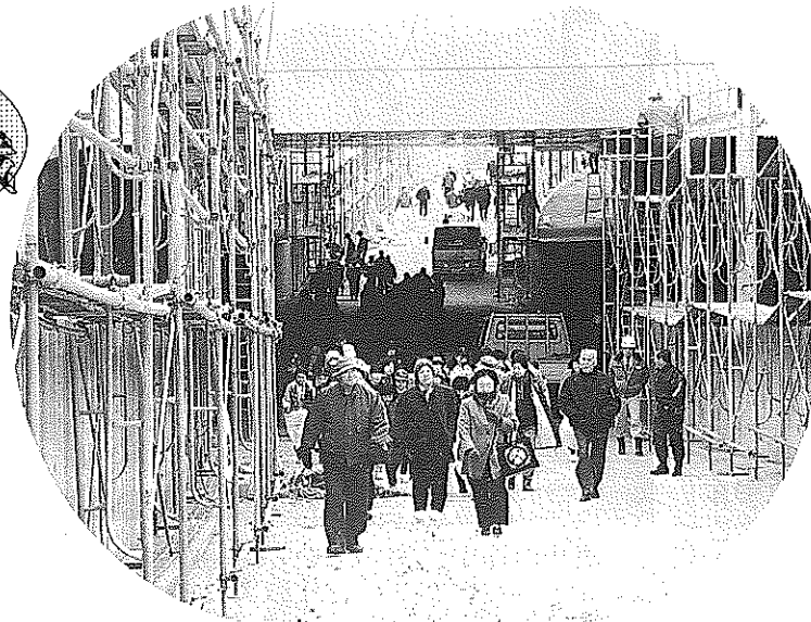
工事関係者の方々のご好意で工事中の山陽本線のゲート下を参加者全員で通過しました。
