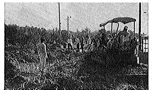
ちびつ子広場の整地作業
