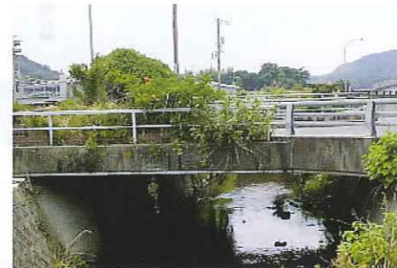
上隅田橋付近
