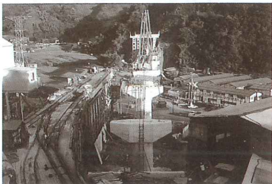
工事のようす(撮影日時不明)
