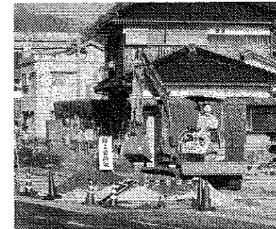
道路拡張工事に着手(土井交差点北側)
