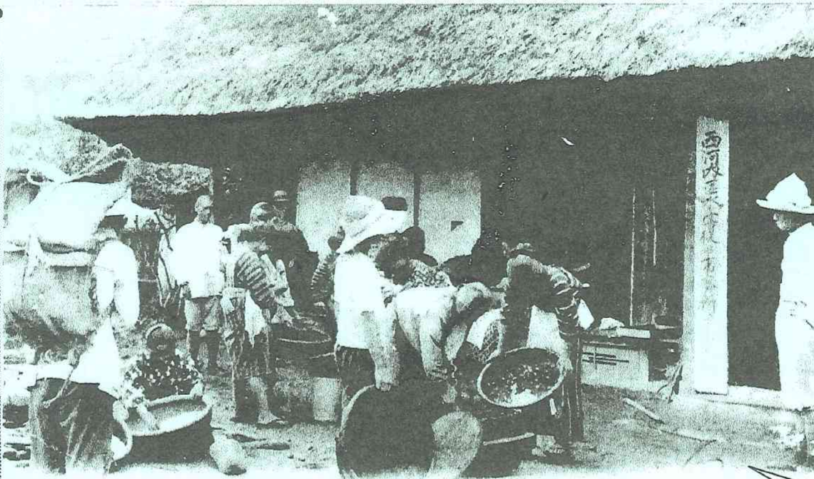
鹿野村西河内地区水害被害状況＝復旧作業中＝飯ノ山、山ノ内
